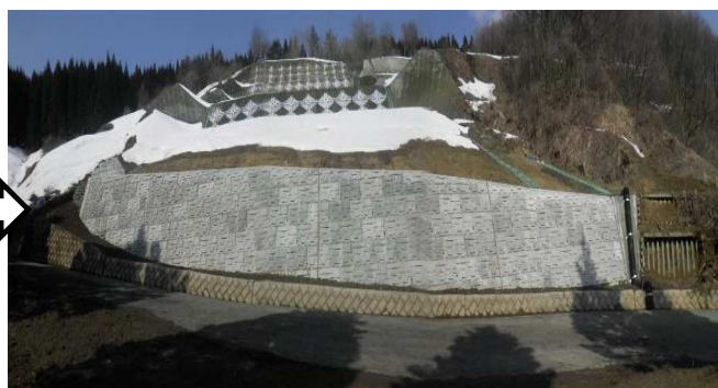
復旧工事完了
