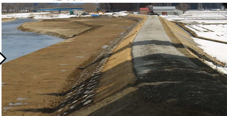
復旧工事完了
