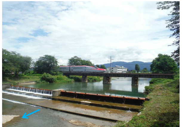
《JR橋の架替えに着手した斉内川(大仙市)》
