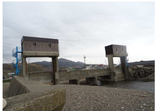
《上屋の更新に伴い、耐震化を実施した水門》 (浜田・八森海岸(泊川水門) 八峰町)
